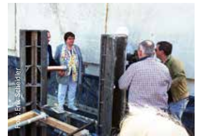
Die Zeitkapsel wird im Fundament des neuen Anbaus versenkt.
